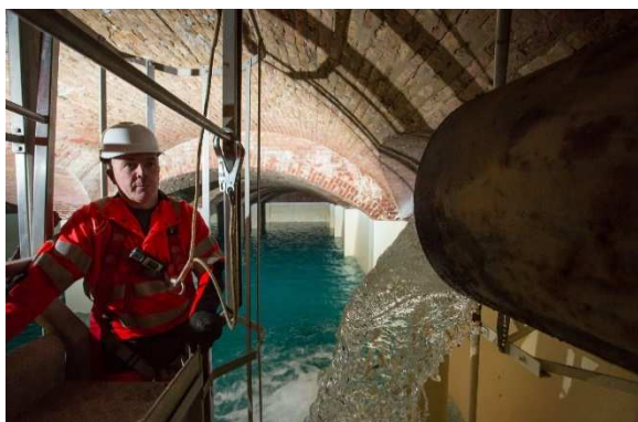
Production d'eau potable
