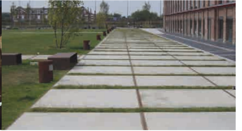
Écoquartier des Rives de la Haute Deûle - Lille
