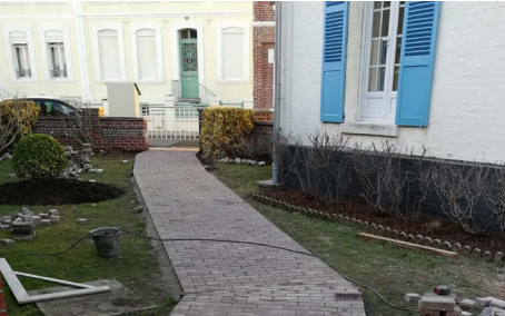
Les travaux d'accès à la bibliothèque
