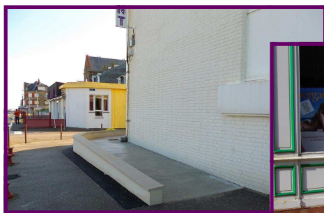
Accessibilité : construction de 3 rampes
